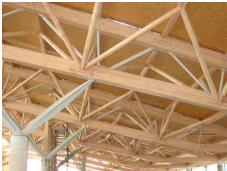
Estructura de douglas, Fusta laminada encolada
